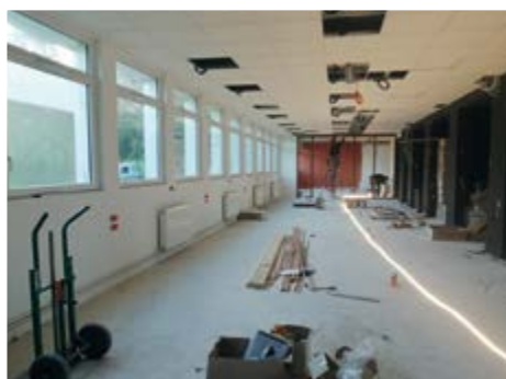
La salle de lecture, zone où seront installés des postes informatiques.
